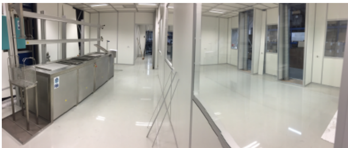
Foto september 2017, nieuwe cleanroom in aanbouw.
